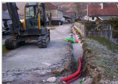
Travaux d'enfouissement des câbles entre la station et le capteur
