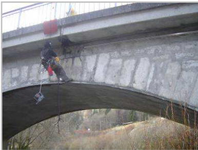
Travaux acrobatiques pour fixer et protéger les capteurs
