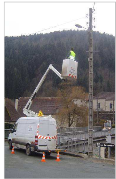
Raccordement des stations au réseau téléphonique
