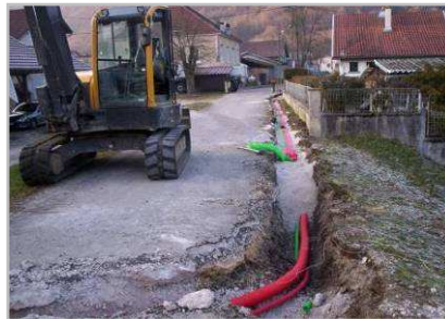
Travaux d'enfouissement des câbles (réseaux RTC et EDF)
