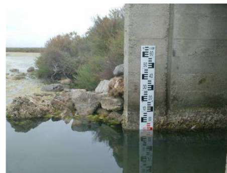
Echelle limnimétrique installée sur support béton existant
